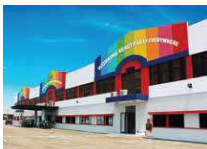
Nhà máy Nippon Paint tại Biên Hòa, Đồng Nai Nippon Paint Factory in Bien Hoa, Dong Nai Province
