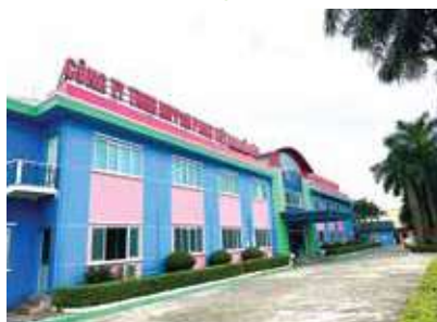
Nhà máy Nippon Paint tại Quang Minh, Hà Nội Nippon Paint Factory in Quang Minh, Hanoi
